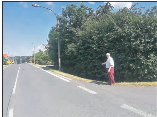
Starosta Loskot: „Při stavbě nového chodníku ve Slánské ulici budou také vyměněny staré kandelábrы za nové uliční osvětlení.“
