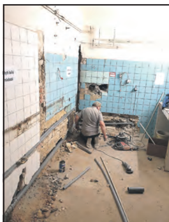
Rekonstrukce mycího koutu restaurace.
