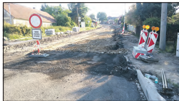
Rekonstrukce silnice I/16 v obci Hvězda. Foto Jiří Loskot
