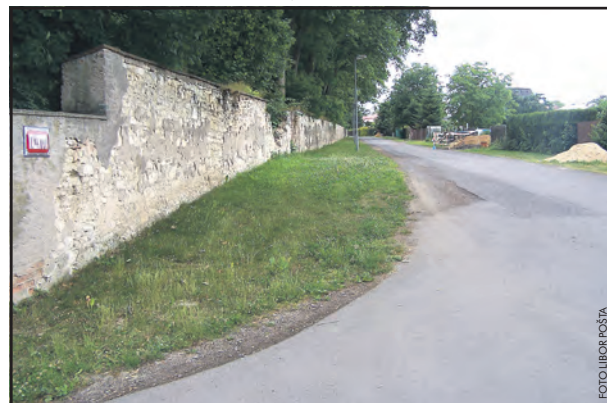
Zhotovenou kanalizační síť ve Valentově ulici chce městy Mšec reklamovat.
