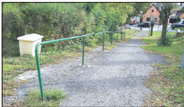
„Krásné“ zábradlí podél pěšiny pod kostelem asi jen tak nezmizí.
