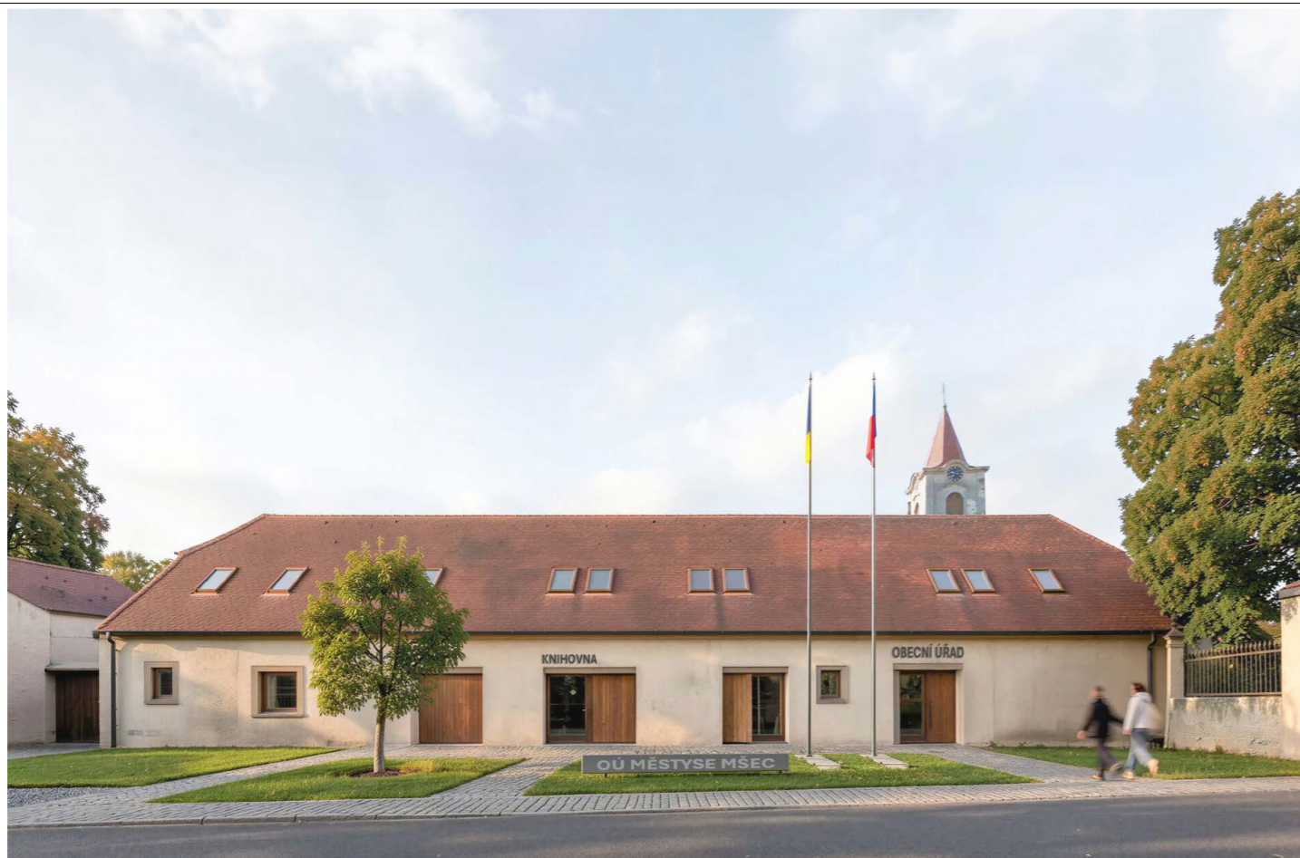
01 ČELNÍ FASÁDA SMĚREM DO ZÁMECKÉHO PARKU
