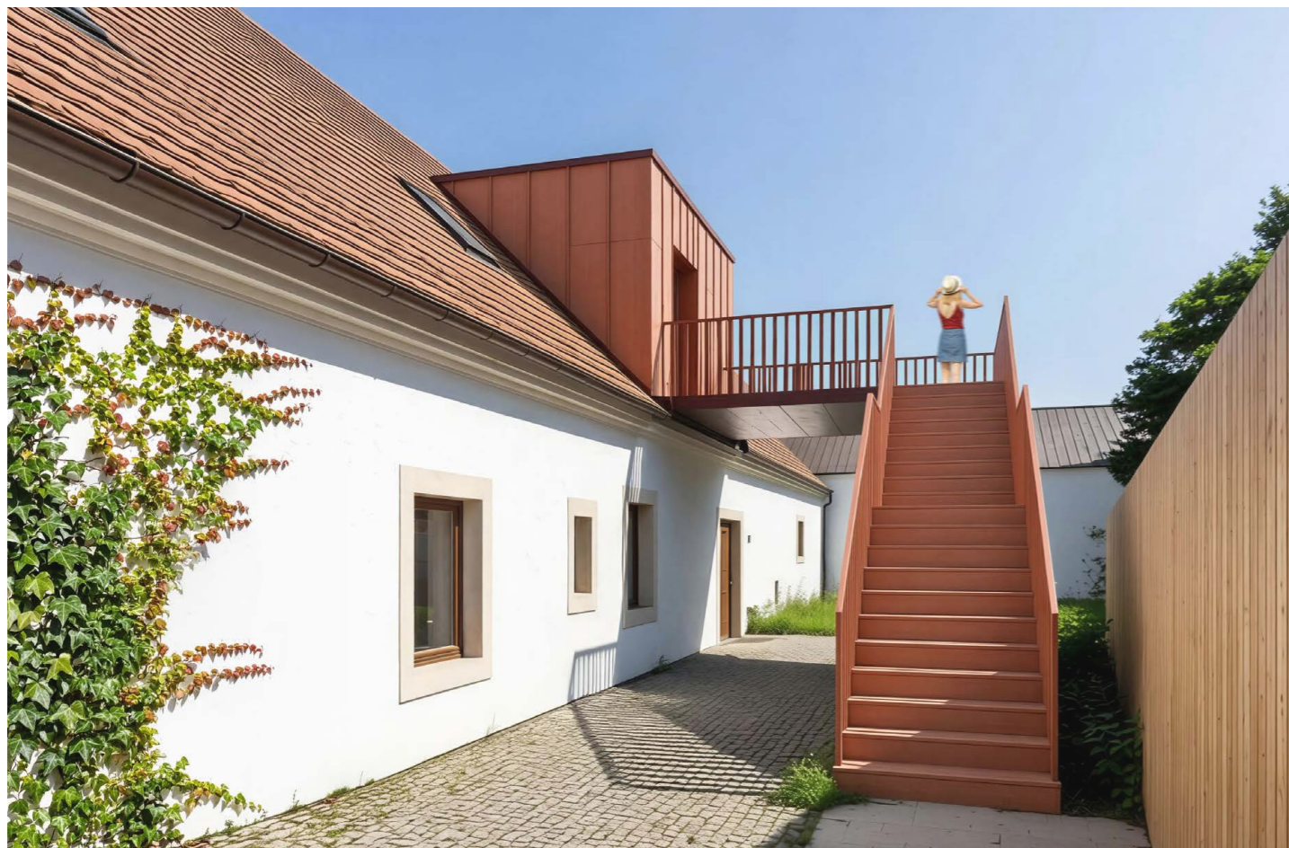
03 POHLED NA PŘÍSTUPOVÉ SCHODIŠTĚ DO PODKROVNÍCH BYTŮ
