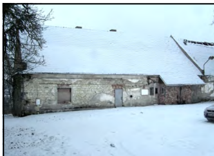
V tomto domě na nádvoří mšeckého zámku vzniknou nové obecní byty.
